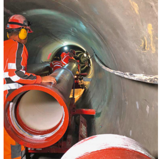
Rohrmontage DN 400 mit Zink-Epoxy-Beschichtung an der Industriestrasse.
