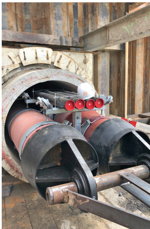
Ankunft am Zielschacht. Deutlich erkennt man die äusserst engen Platzverhältnisse im Microtunnel.
